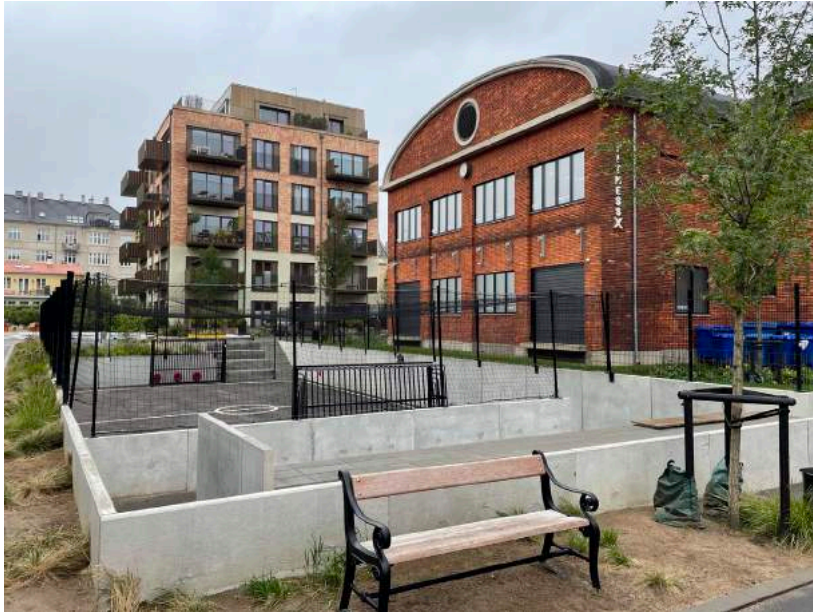
I Carlsbergbyen er der etableret urbane regnvandsløsninger som fx boldbaner i beton.
