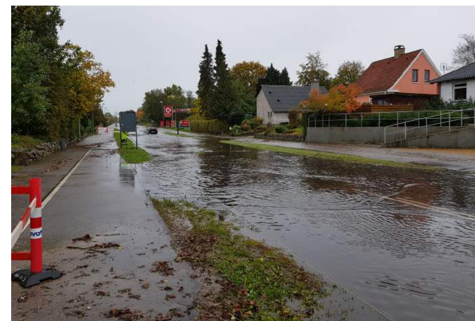
På Hovvej er der problemer med oversvømmelser efter skybrud. Foto: Helsingør Kommune.
