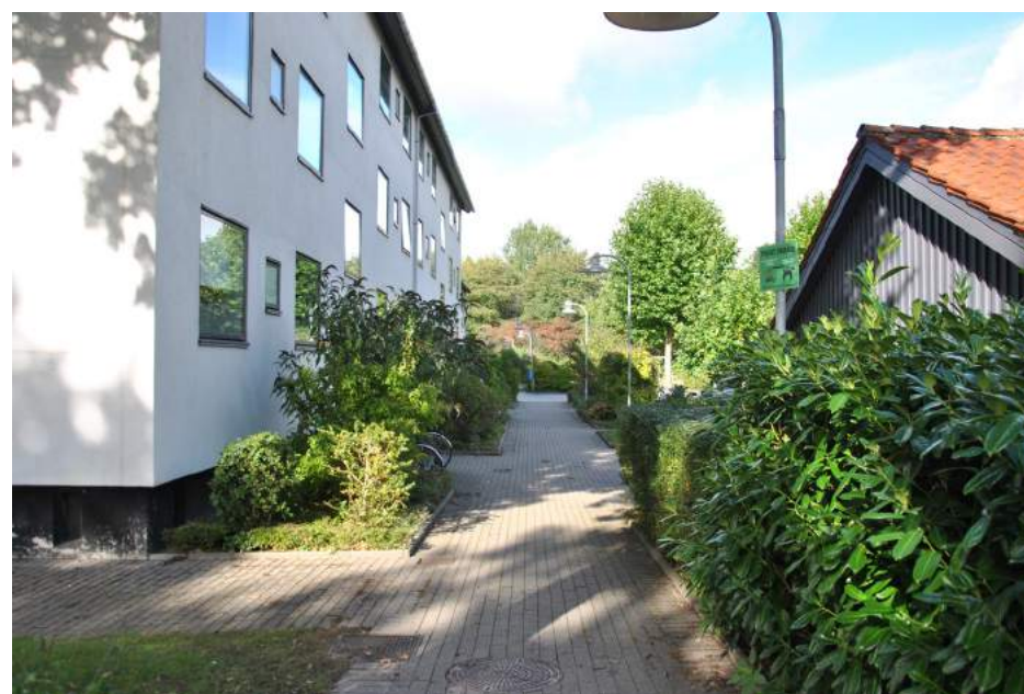
I nogle boligområder, hvor terrænet visse steder ligger lavt, ophober der sig meget vand ved store regnskyl - fx her ved Søndermarken.
