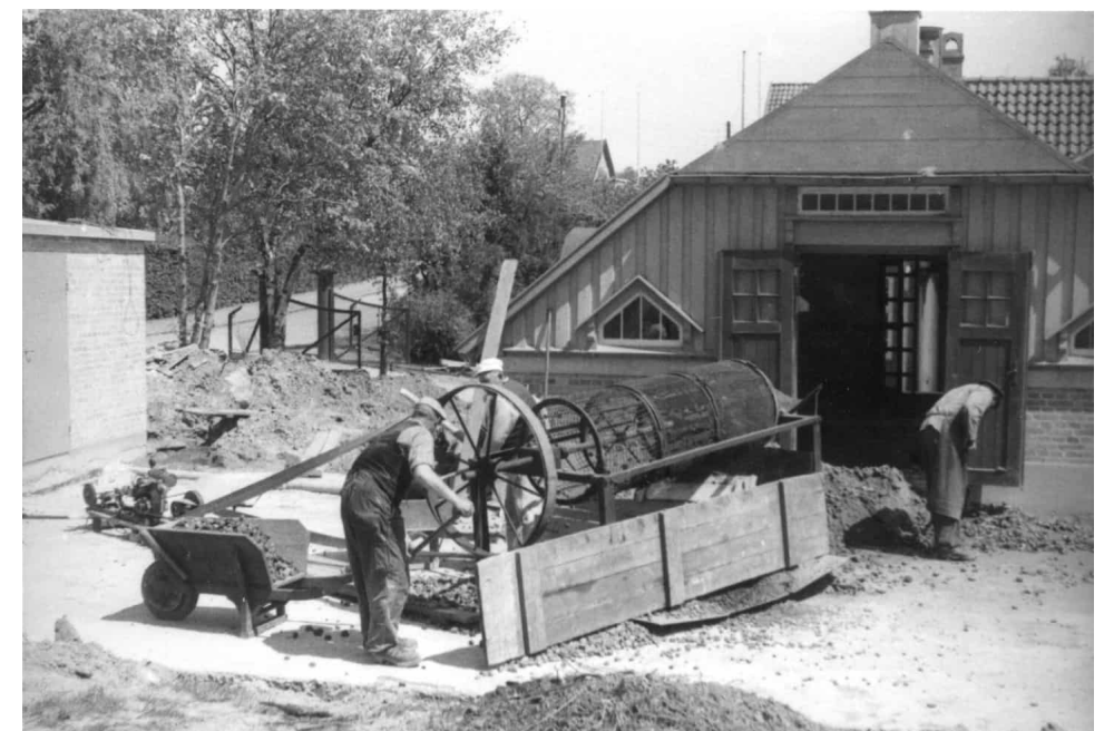
Filtersand til rensning af vand.
